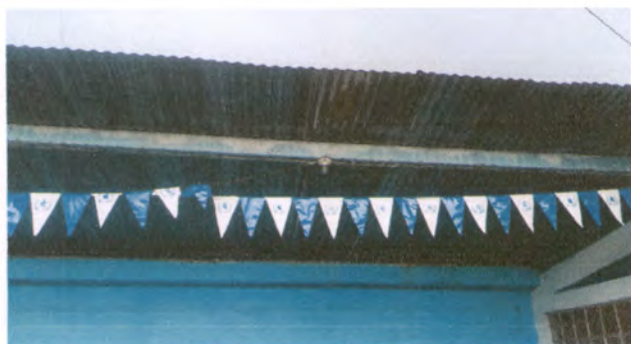
Foto 1: Sustrucción de lámina, por lámina troquelada aluzinc calibre 26, sustrucción de estructura de soporte de metal por metal
