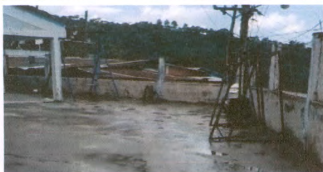
Foto 3: Reparación de muro perimetral de block
