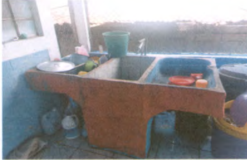
Foto 7: Sustrucción de pila de cemento de dos lavaderos
