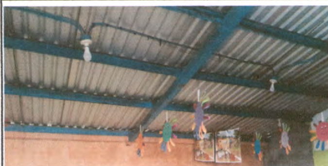
Foto 5: Reparación de sistema eléctrico
