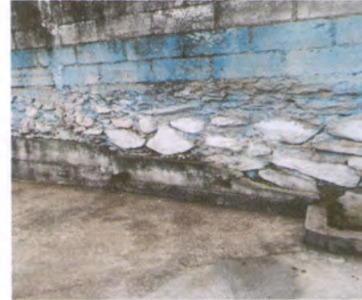
Foto 8: Repello en muro y alisado en muro
